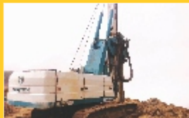
2011 Casagrande B180 HD Piling Rig
